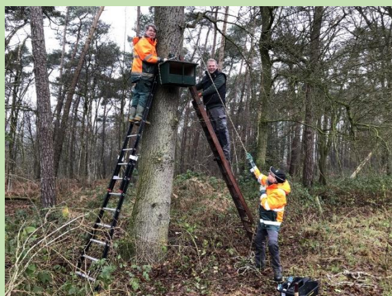
Hier wordt op hoog niveau gewerkt
