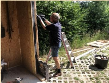
Ook slopen is vakwerk
