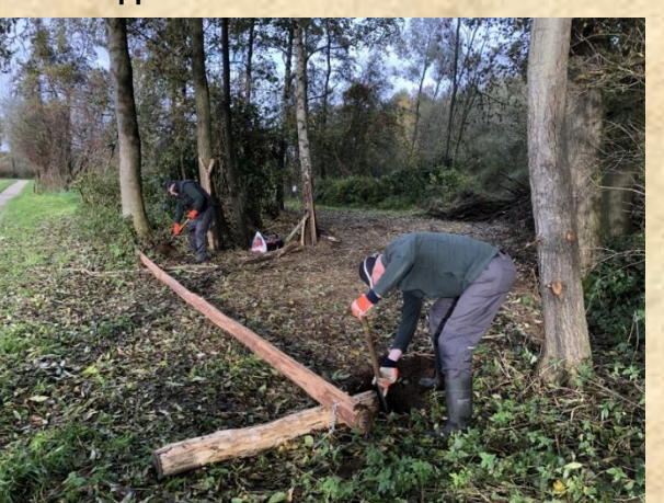
Plaatsen nieuwe slagboom
