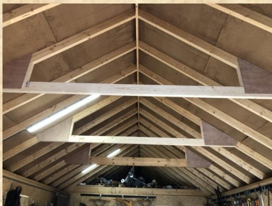
Gebinten hoger aangebracht en verstevigd
