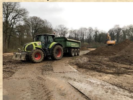
Grondwerk Lebbenbrugge door Hobelman - Halle
