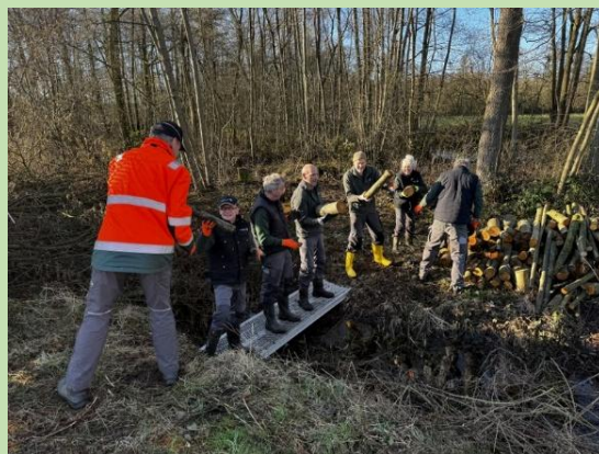
Afvoeren van het hout
