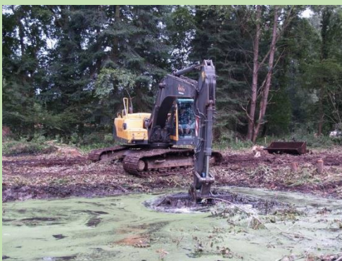
De poelen werden uitgebaggerd
