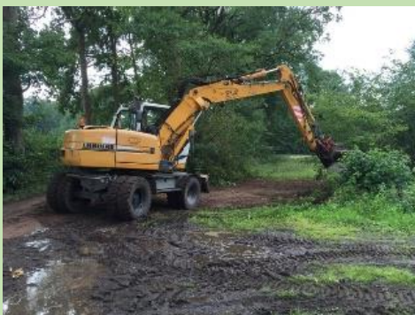
Aanleg van de tijdelijke uitrit
