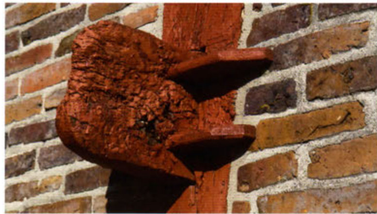
Een pen-gatverbinding uit de tijd dat er nog geen spijkers en schroeven waren.
